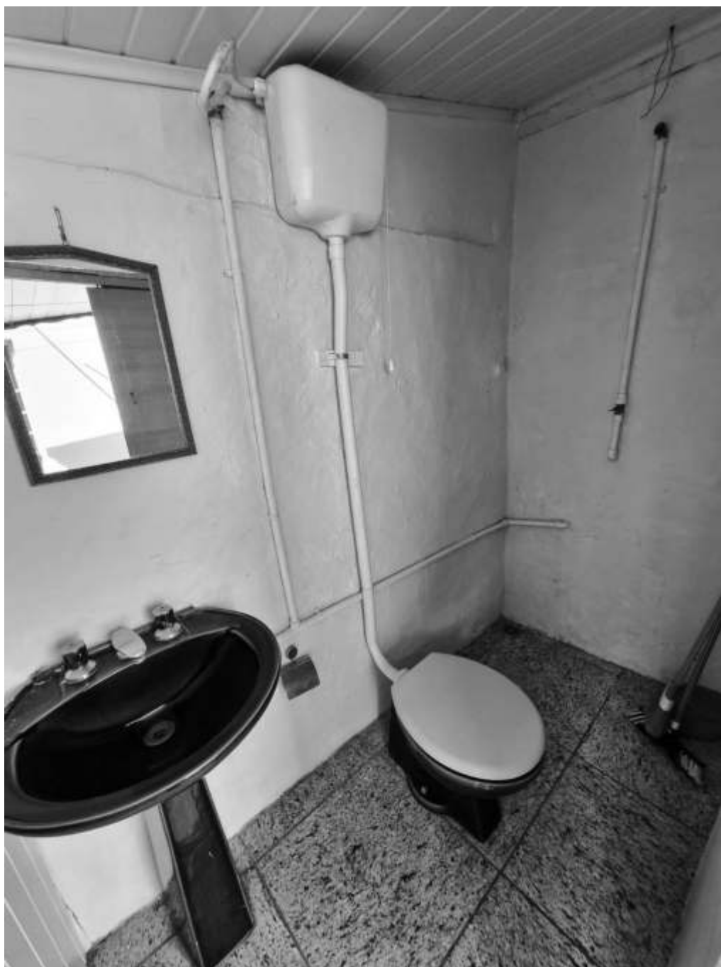
Foto 19 – Vista do banheiro da área externa dos fundos.
