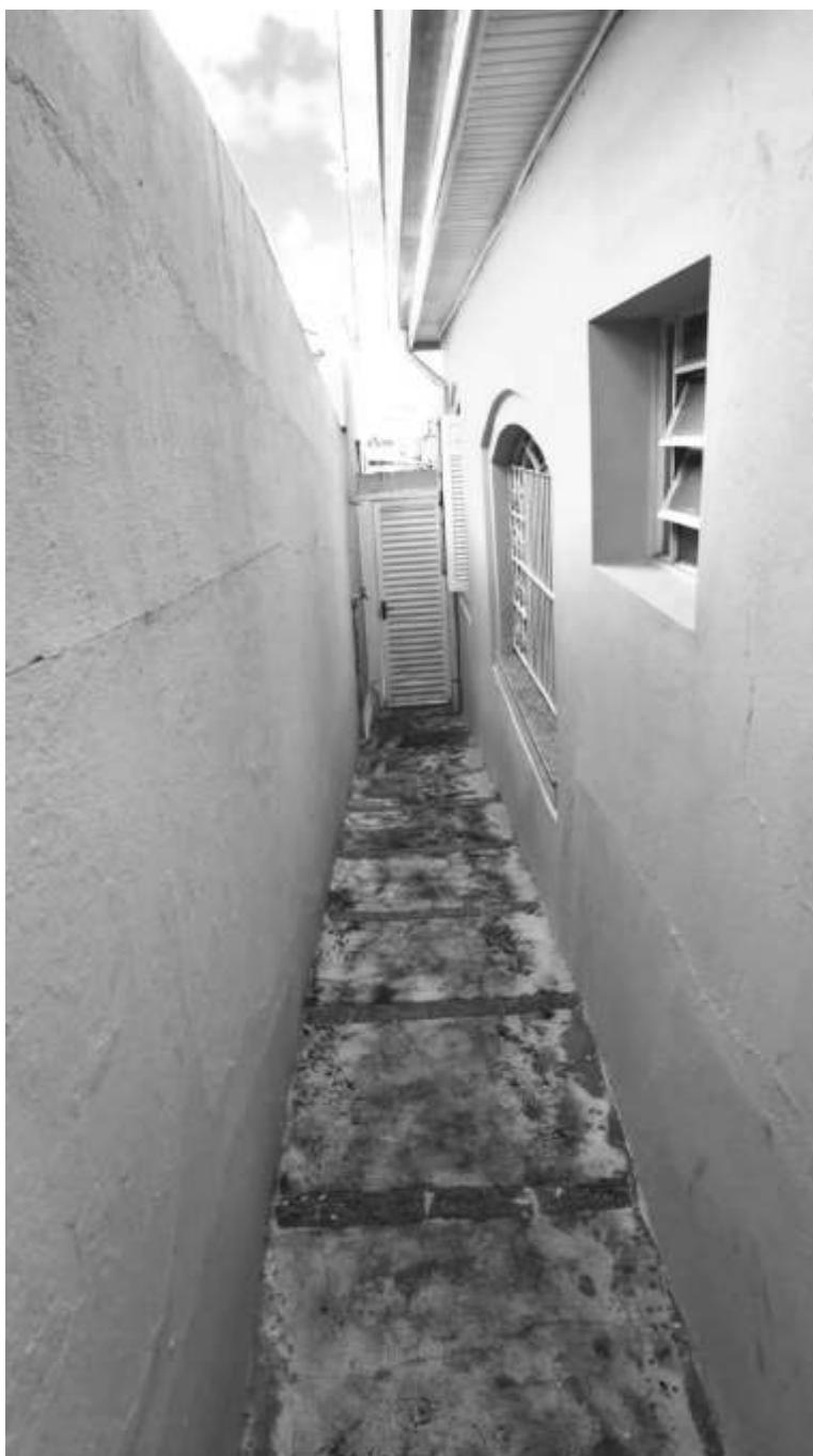
Foto 15 – Vista do corredor lateral externo.
