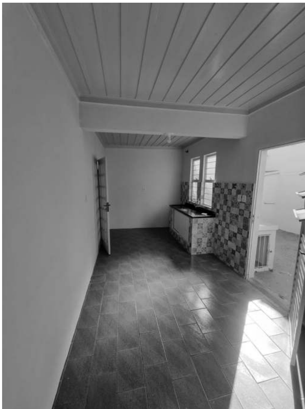
Foto 12 – Vista da cozinha.
