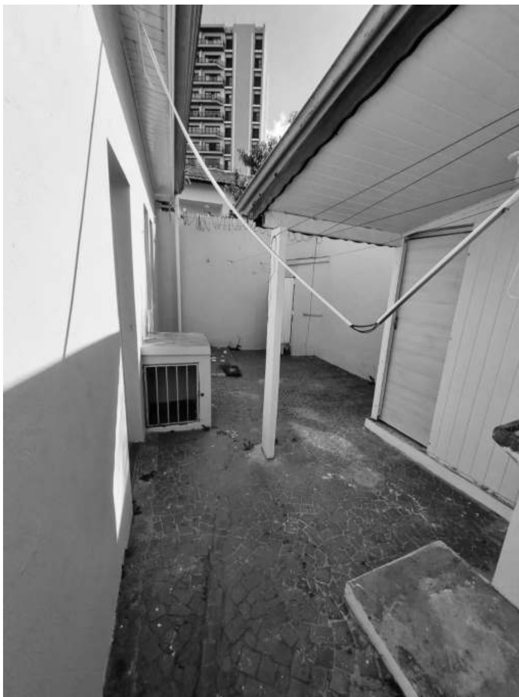
Foto 16 – Vista da área externa dos fundos.
