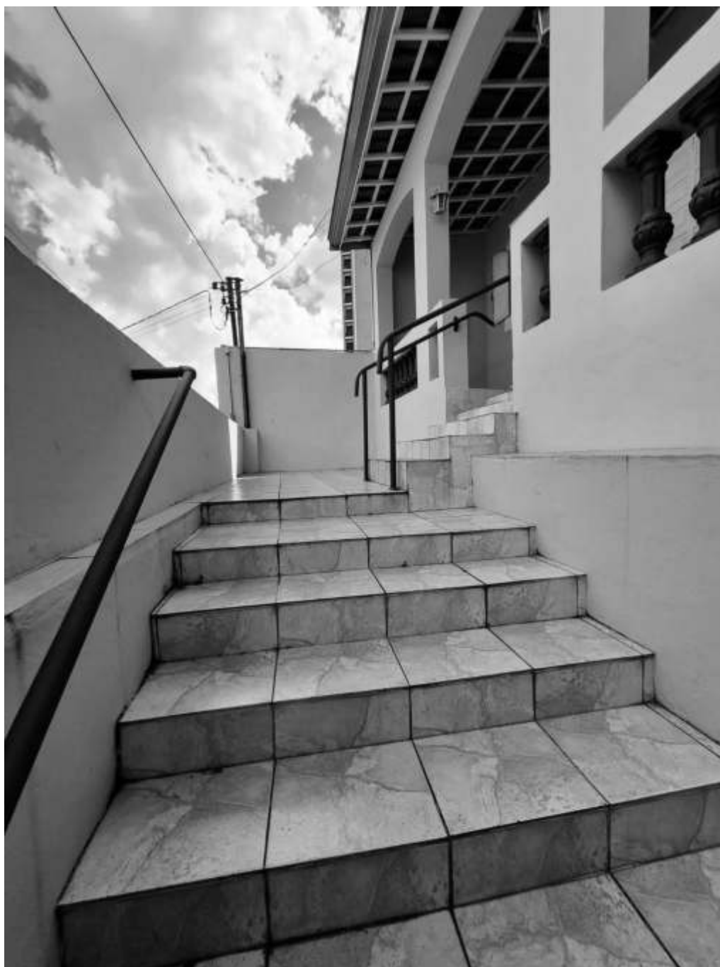
Foto 05 – Vista da escadaria de acesso à entrada principal do imóvel.
