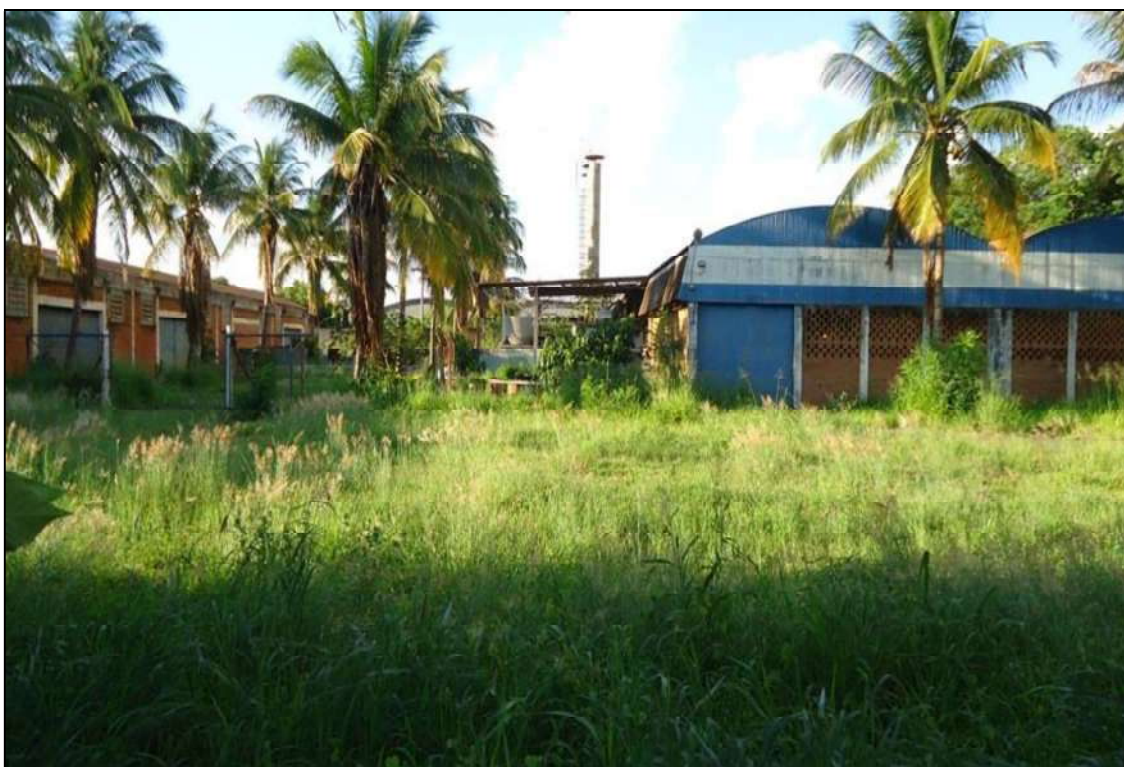
Foto 05 – Vista dos barracões do imóvel industrial (objeto do contrato).
