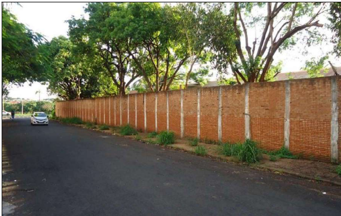
Foto 08 – Vista do muro de divisa do imóvel industrial (objeto do contrato) com a Rua Professor Norberto Castro.
