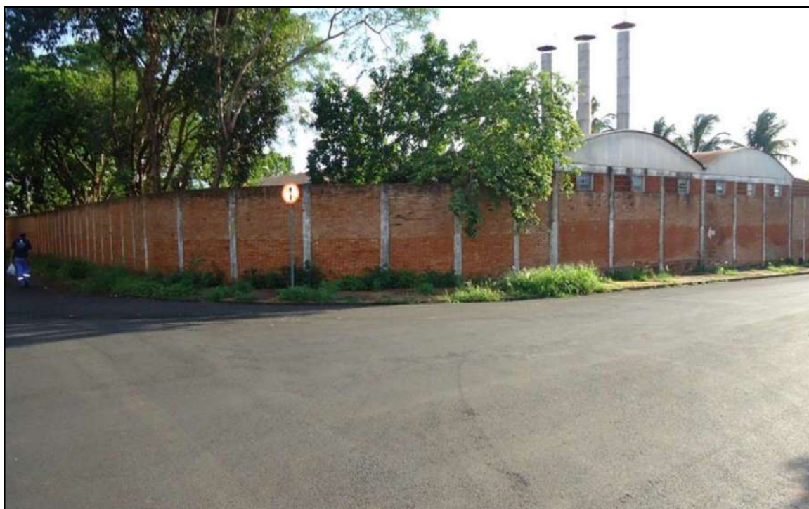
Foto 07 – Vista do fundo do imóvel industrial (objeto do contrato) no cruzamento das Ruas Cel. Cândido Procópio de Oliveira e Professor Norberto Castro.
