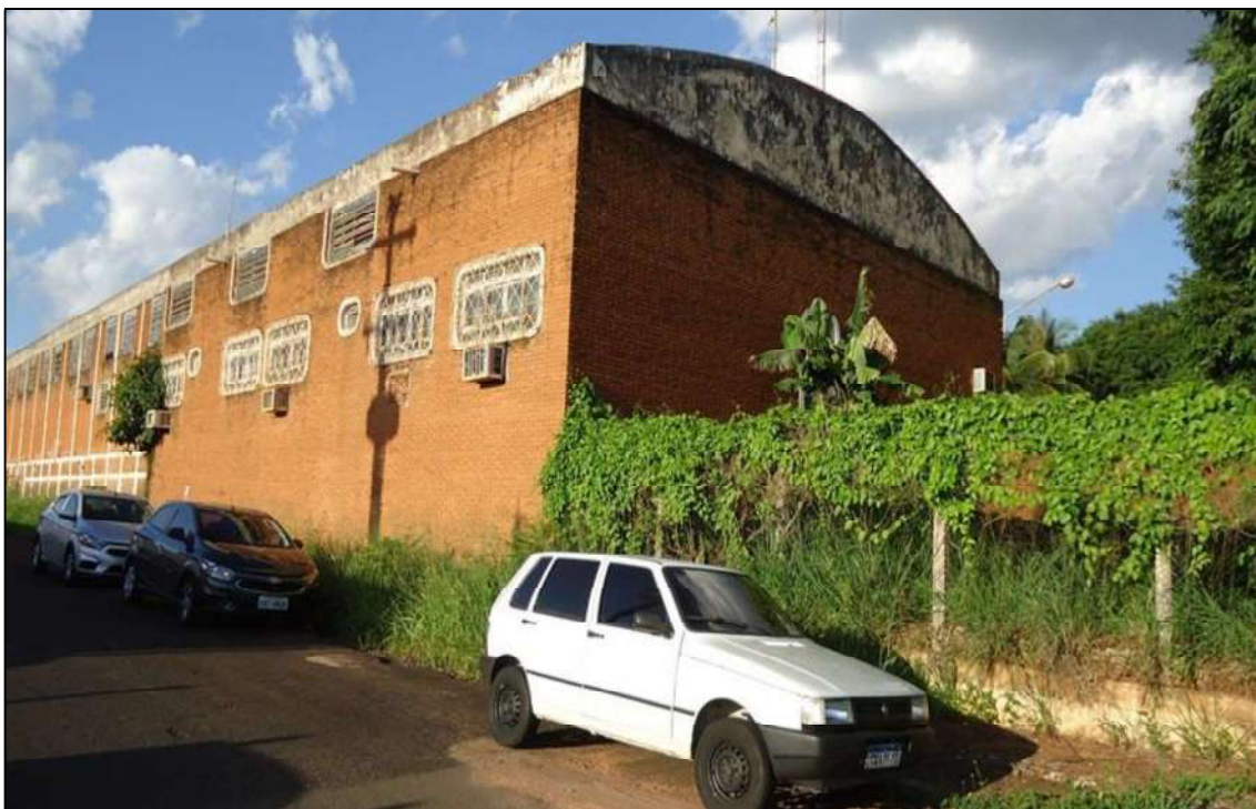
Foto 11 – Vista do barracão do imóvel industrial (objeto do contrato) com a divisa para a Rua João Gutemberg.
