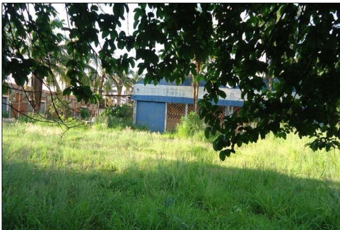
Foto 03 – Vista frontal do imóvel industrial (objeto do contrato).
