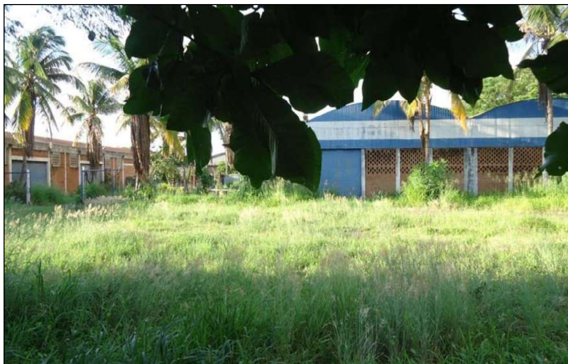
Foto 04 – Vista frontal do imóvel industrial (objeto do contrato).
