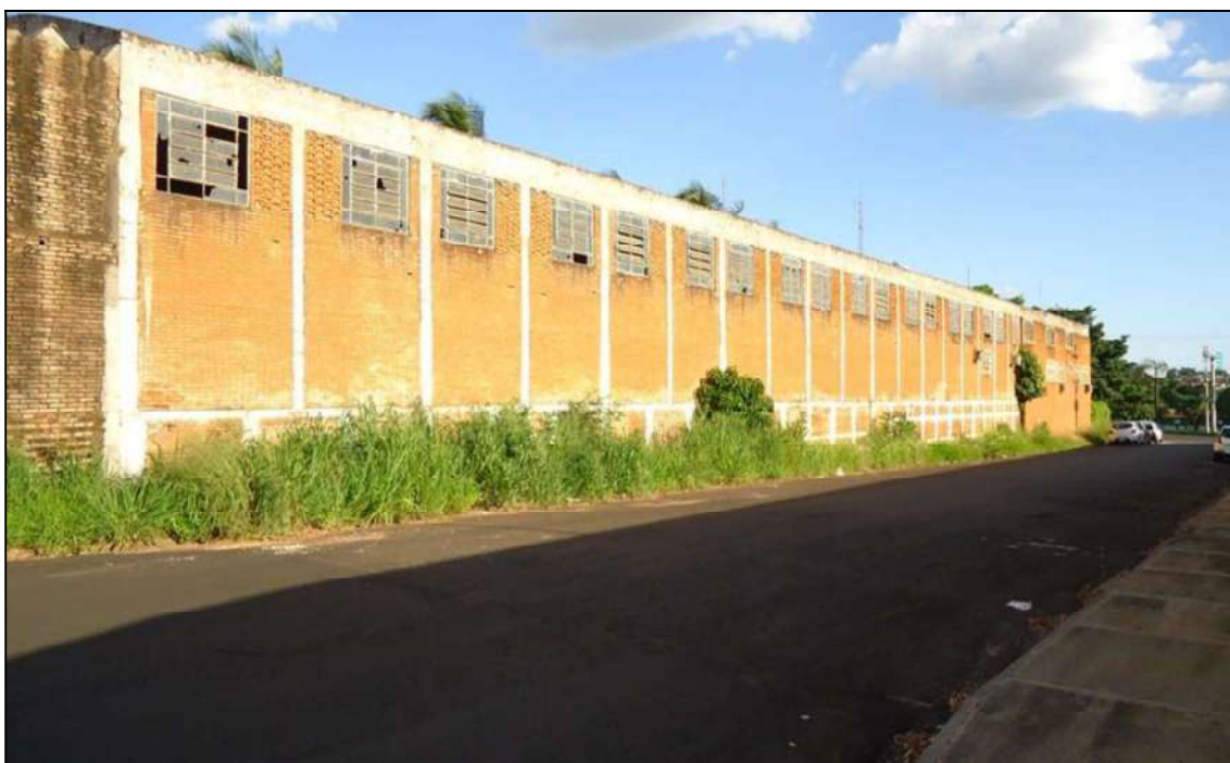
Foto 10 – Vista da parede de divisa do barracão do imóvel industrial (objeto do contrato) com a Rua João Gutenberg.
