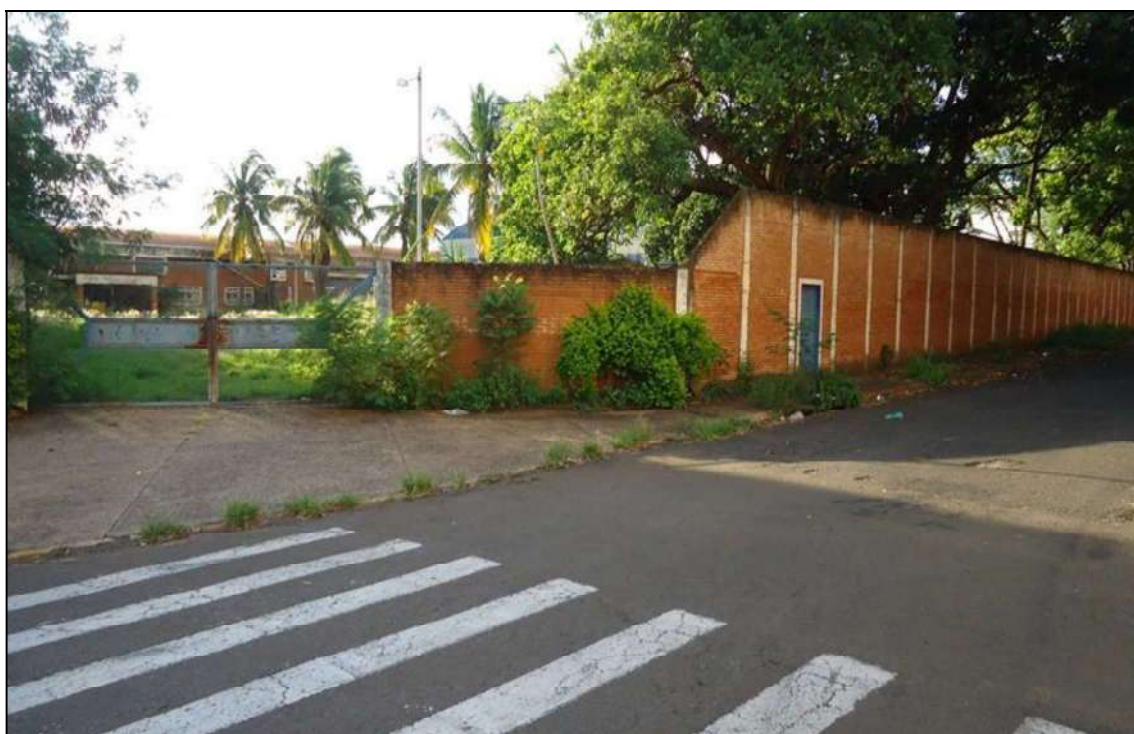
Foto 01 – Portão de acesso ao pátio do Imóvel industrial (objeto do contrato)
