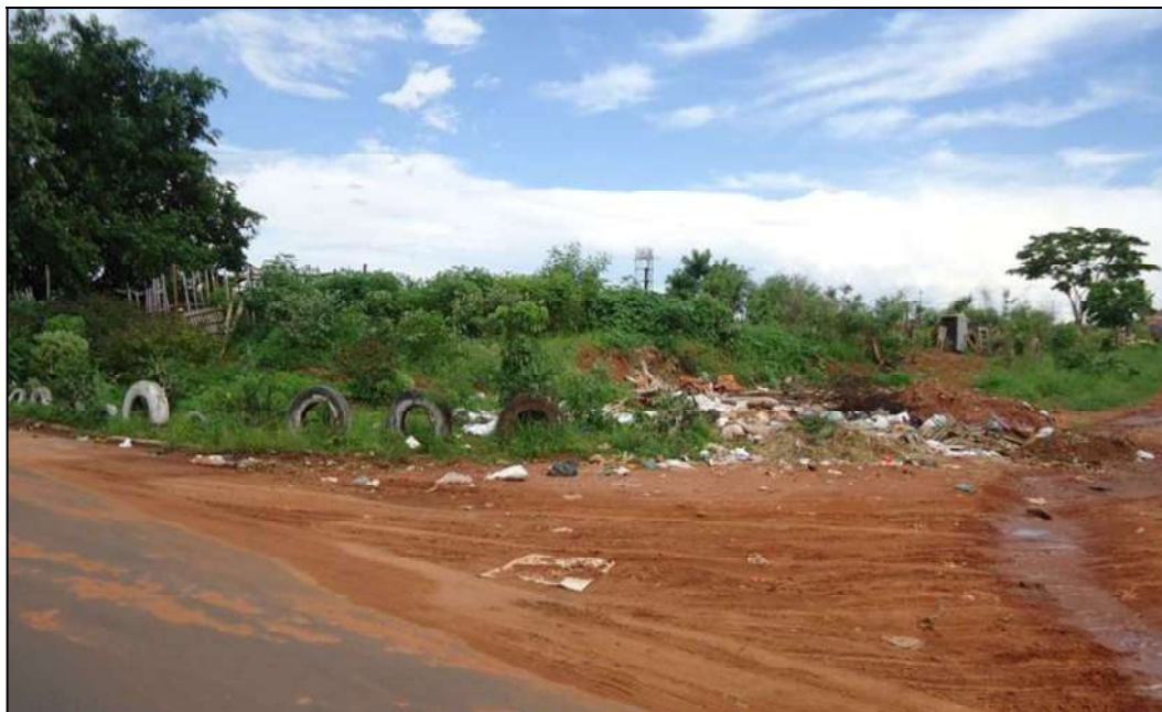
Foto 02 – Vista Frontal da Frente do Lote 397 da quadra 101.153, na esquina com a Rua Belarmino Francisco Silva (não possui infra estrutura)
