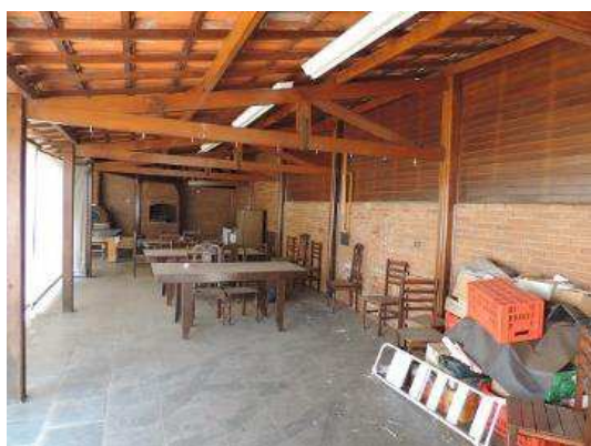
Imagem 96 – detalhe de área anexa coberta, imóvel 04
