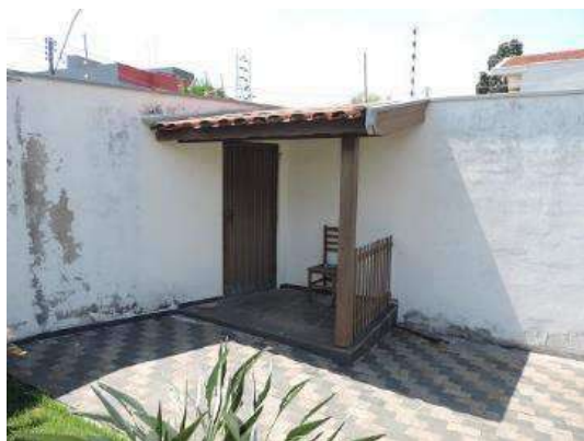
Imagem 102 – cobertura em entrada do imóvel 04
