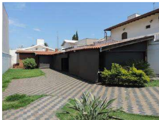
Imagem 93 – imagem interna de terreno, imóvel 04
