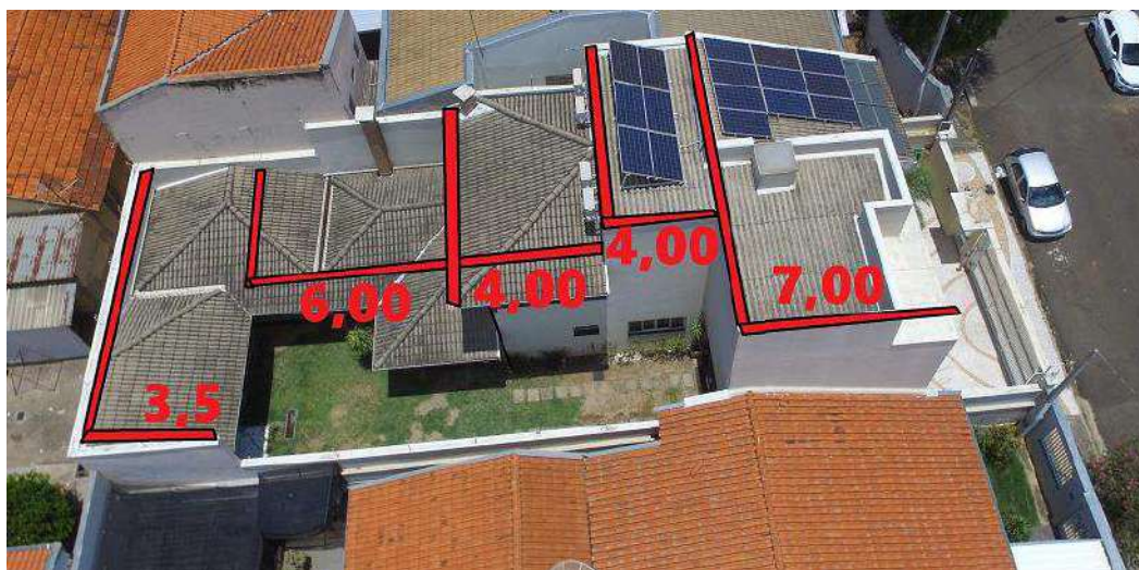
Imagem 23 - Detalhe com croqui sobreposto de dimensões estimadas na dimensão perpendicular à rua (os dois primeiros blocos apresentam dois pavimentos)
