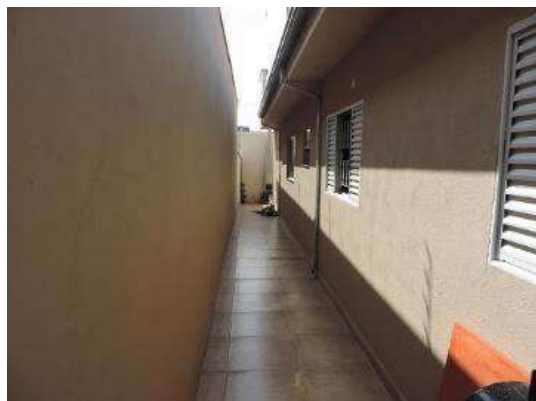
Imagem 62 – corredor externo, imóvel 01
