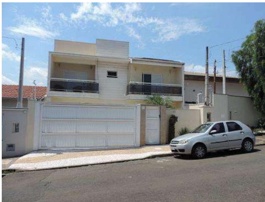
Imagem 18 – Fachada de imóvel 06
