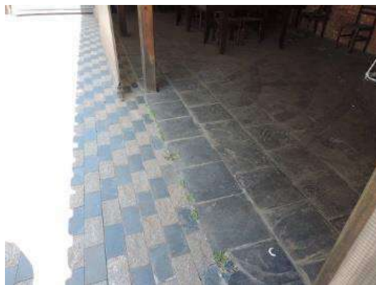
Imagem 99 – detalhe de piso em ardósia (interno) e pedra natural (externo), imóvel 04
