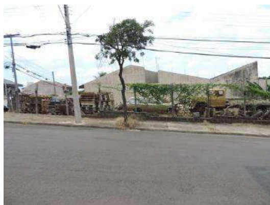
Imagem 91 – detalhe de lateral de terreno, imóvel 03
