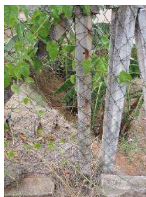
Imagem 89 – detalhe de divisa do terreno, imóvel 03
