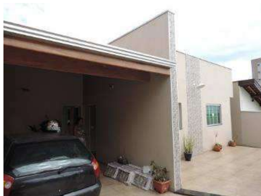
Imagem 39 – entrada principal, imóvel 01
