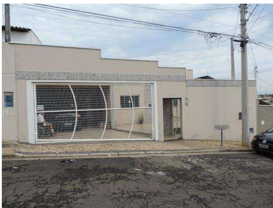
Imagem 09 – Fachada / frete do imóvel 01
