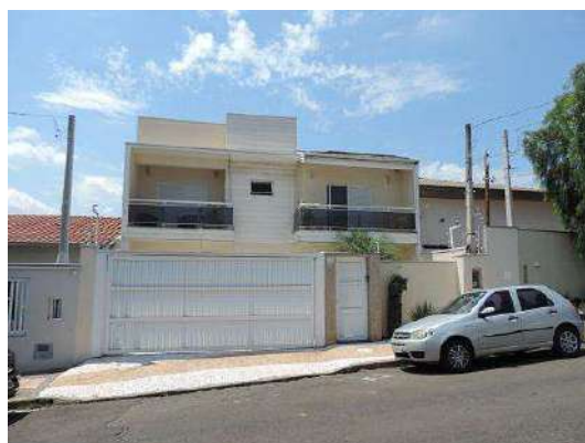
Imagem 125 – fachada do imóvel 06
