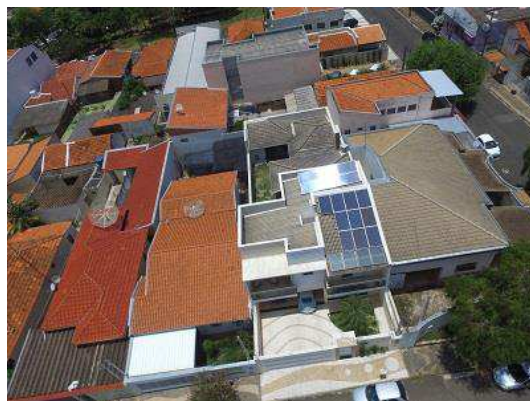
Imagem 123 – foto de drone do imóvel 06
