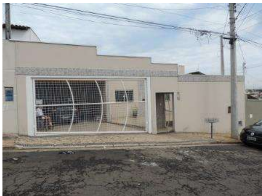
Imagem 38– fachada do imóvel 01
