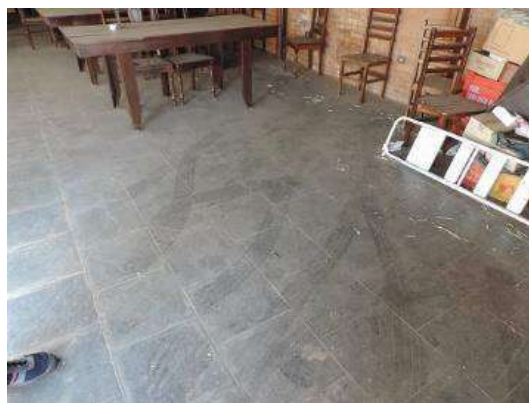
Imagem 103 – detalhe de piso do imóvel 04
